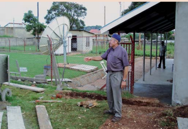
Bei den Bauarbeiten an der Radiostation in Gulu
